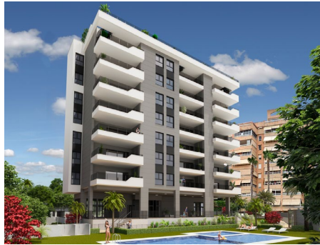
Calma ad home Alicante 21 viviendas BTS 2
