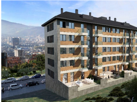
Vía Vieja de Lezama Bilbao, Vizcaya 40 viviendas BTS 2
