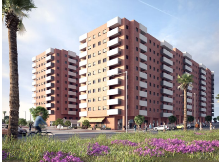
Montequinto ad home Dos Hermanas, Sevilla 197 viviendas BTS 2
