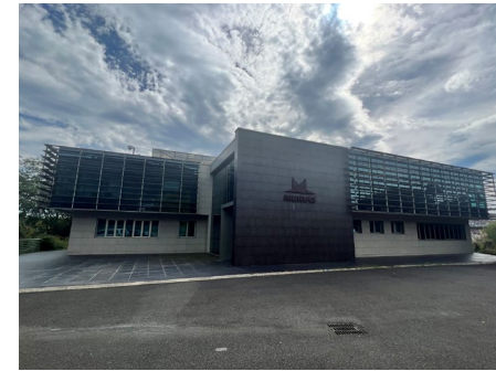
Edificio oficinas Murias San Sebastián, Guipúzcoa 845 m 2
