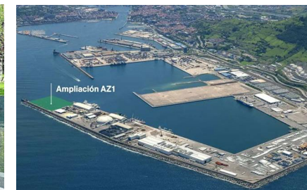
Ampliación del muelle AZ-1 – Bilbao, Spain 27M€ - In execution
