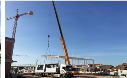
Escuela Secundaria – Valencia, Spain 6M€ - en ejecución
