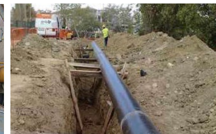
Construcción de la red de gas– Faro, Portugal 1M€
