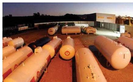
Renovación de los depósitos de glp– Portugal 800K€
