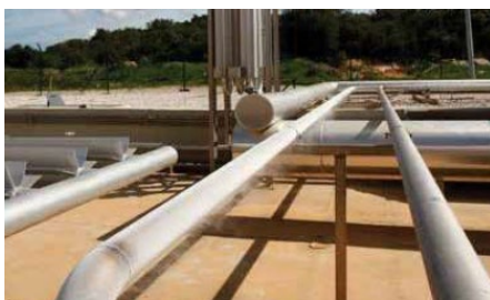
Construcción de red de gas– Portugal 450K€
