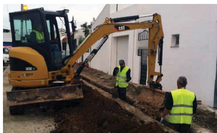
Construcción de red de gas– Portugal 16M€ - en ejecución
