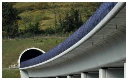
Alta velocidad Pamplona-Zaragoza – Spain 17M€
