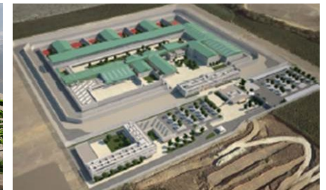
Nuevo Centro Penitenciario – S.S, Spain 39M€ - en ejecución
