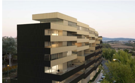
Vivienda Protegida– Navarre, Spain. 7M€ - en ejecución
