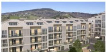
Edificio Usúrbil Fase 1 28 dwellings
