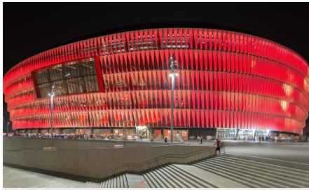
New San Mamés Stadium – Bilbao. Spain 173M€
